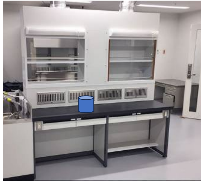
局所排気装置（外付け式）
